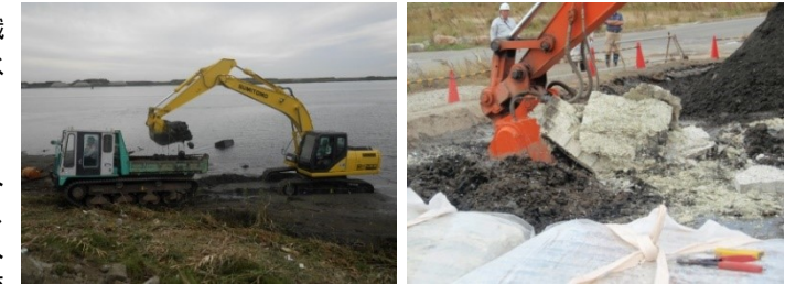
写真 1 津波堆積物の浚渫と運搬 写真 2 津波堆積物と古紙破砕物の攪拌・混合
