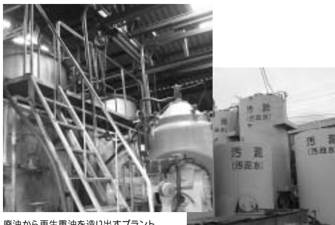
廃油から再生重油を造り出すプラント
