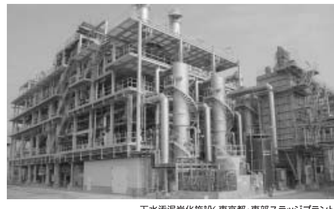
下水汚泥炭化施設(東京都・東部スラッジプラント)
