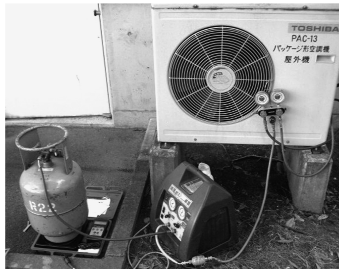
冷媒ガスの回収
