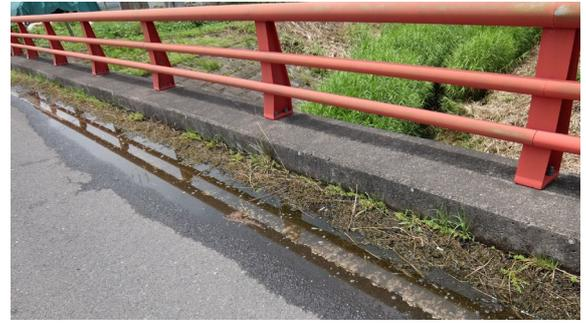
図-3 堆積土砂等により排水できない状態
