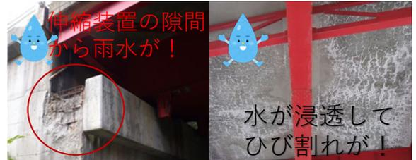
図-4 雨水による床版、桁端部の劣化
